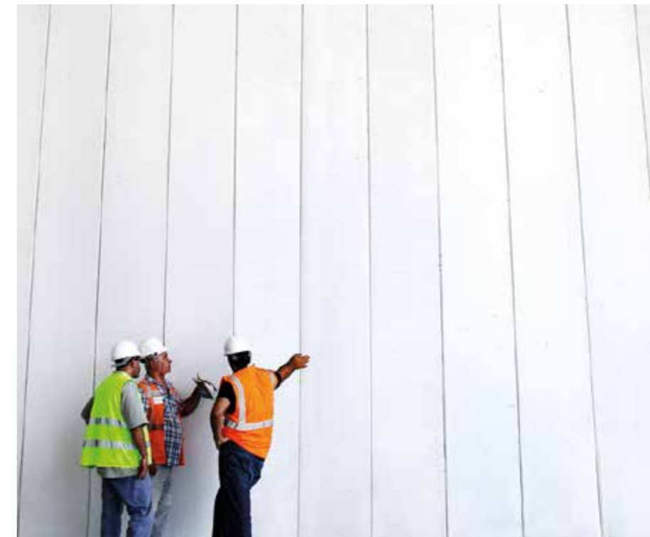
15 cm kalınlıktaki Ytong yangın duvarı ile 6 saate kadar yangın dayanımı sağlanabilir.
